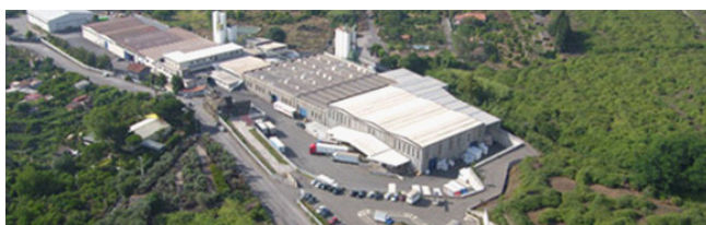
Veduta aerea Azienda
